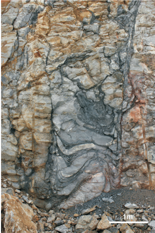
Abb. 6: Kollabierter Karsthohlraum, Sedimentfüllung überwiegend durch Grauwacke; Iberg, 2015.
