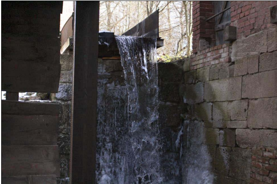
Abb. 6: Obermühle an der Brehme in Duderstadt (Quelle: Aufnahme Kohlstedde, www.obermuehle-duderstadt.de )
