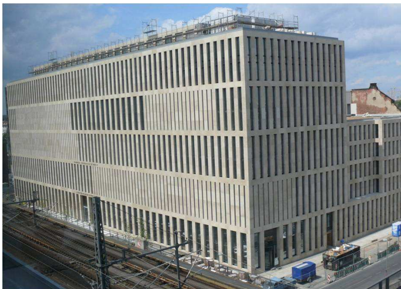
Fassade des Jacob-und-Wilhelm-Grimm-Zentrum zur Bahn (Foto: Milan Bulaty)
