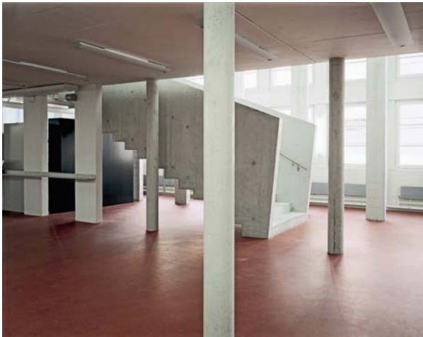
Alt und neu vereint: Gut sichtbar sind im Hauptgebäude der Nationalbibliothek der grobe Beton der Stützen und Decke von früher und der feine Sichtbeton der Stützen und Treppen von heute. (Fotos: Marco Schibig, © Bundesamt für Bauten und Logistik)
