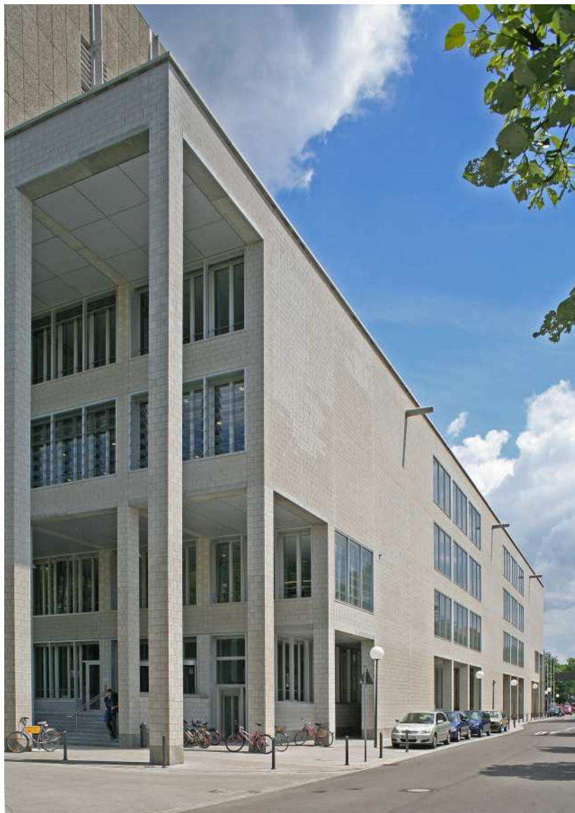
Westeingang und Fassade (Foto: Thilo Mechau, Inst. f. Baugestaltung, Universität Karlsruhe)
