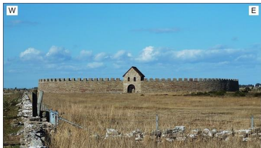
Abb. ÖS 3.1: Burg Eketorp; Blick vom Info-Zentrum nach Norden (Foto: Gert Schneider 2015).
