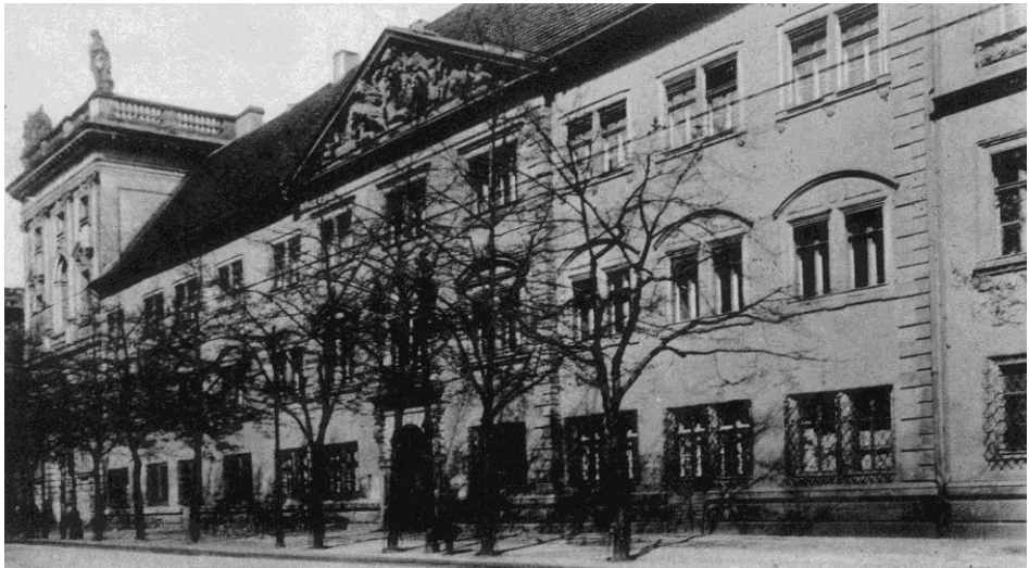
Abb. 7: Neues (linker Hintergrund) und altes Marstallgebäude in Berlin Mitte. Aufnahme von 1896, ohne Kriegsbeschädigungen (bpk)
