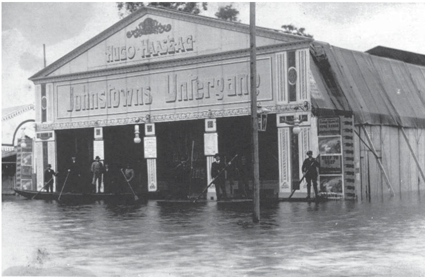
Abb. 1: Hochwasser der Donau im September 1912. Überfluteter Festplatz in Straubing (Stadtarchiv Straubing)
