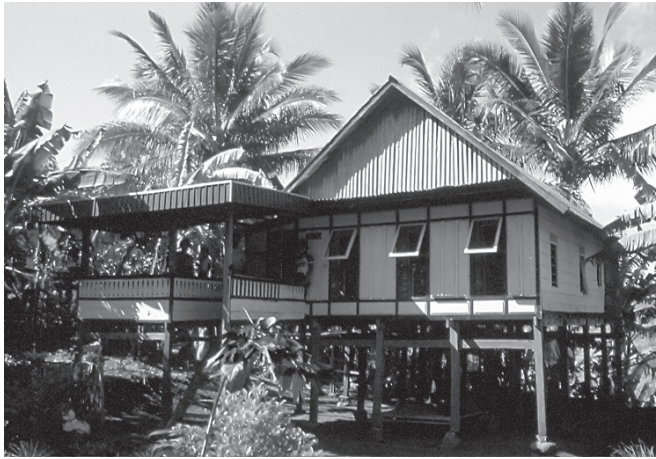
Abbildung 1: Typisches Haus neo-traditioneller Bauart (ca. 1961), mit 34 m 2 von unterdurchschnittlicher Größe, jedoch mit sehr hohen Pfosten und großzügiger Veranda. Der nur einteilige Giebel weist auf niederen Deszendenzrang der Besitzer hin.
