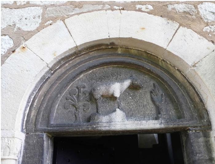
Abb. 92: Portal über dem Nordeingang der Kirche; Aufnahme vom 11.05.2018.
