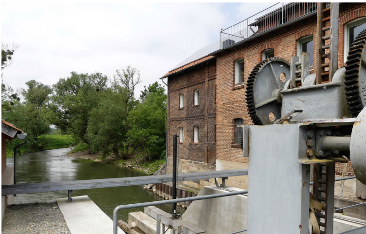
Abb. 111: Mühle in Heinde an der Innerste, Gebäude von 1881, Mühlenstandort vermutlich weitaus älter; Aufnahme vom 17.05.2018.
