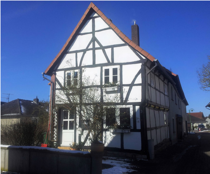
Abb. 201: Pfarrwitwenhaus, Fachwerk wohl mit gebogenen Hölzern von Stockausschlagwald, Gebäude von 1722; Aufnahme vom 19.03.2018.
