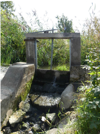
Abb. 227: Wehr auf dem Grundstück der Familie Bobertz. Im Vordergrund der Freikanal, hinter dem Wehr die Lamme; Aufnahme vom 22.08.2018.
