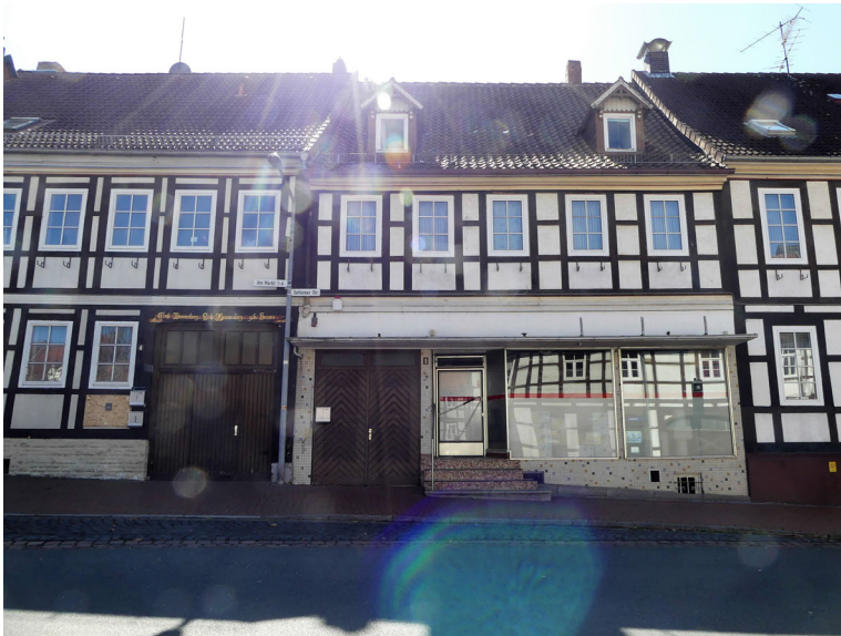
Abb. 188: Leerstehende Ladenzeile im Ortszentrum Bodenburgs (Ecke „Sehlermer Straße“/„Am Markt“); Aufnahme vom 06.04.2018.
