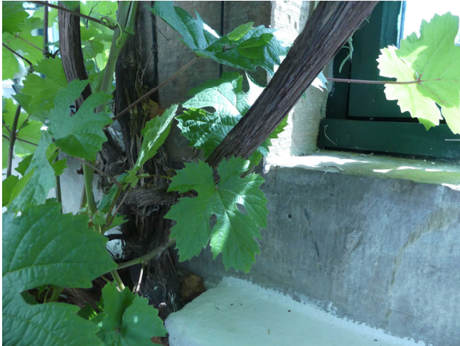
Abb. 156: Detailaufnahme in der Orangerie, dem ehemaligen Gewächshaus von Derneburg. Der Wein wächst von außen in das Gebäude; Aufnahme vom 24.04.2017.
