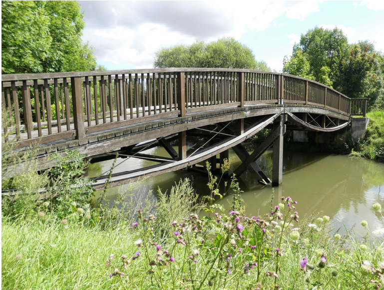
Abb. 164: Nachgebaute Holzbrücke von Laves zwischen Holle und Listringen; Aufnahme vom 14.08.2017.
