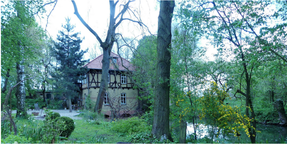
Abb. 166: ehemaliges E-Werk Derneburg; Aufnahme vom 26.04.2017.
