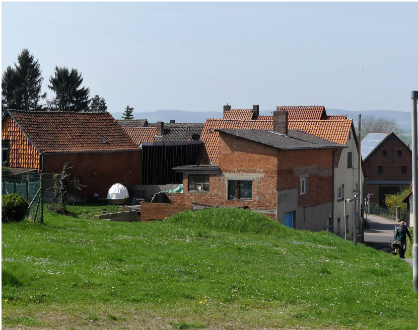
Abb. 175: Quellen am südlichen Ende von Bodenburg an der Straße „An der Drakenburg“: Unter der künstlichen Rasen-Aufwölbung in der Mitte des Bildes ist eine Quelle verdolt; Aufnahme vom 16.04.2018.
