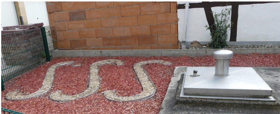
Abb. 33: Verdolung über dem St.-Georgsbrunnen; Aufnahme vom 04.06.2016.
