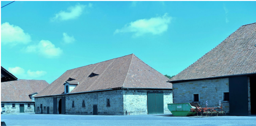
Abb. 158: Ökonomiegebäude auf dem Vorwerk Binder, konzipiert vom hannoverschen königlichen Hofarchitekt Georg Ludwig Friedrich Laves; Aufnahme vom 08.07.2017.
