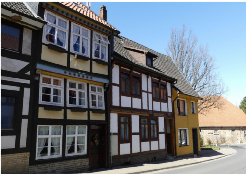
Abb. 178: Gebäude in der Teichstraße (Nr. 11) von 1670 (weißes Haus rechts im Bild) innerhalb des Bodenburger „Ts“; Aufnahme vom 06.04.2018.
