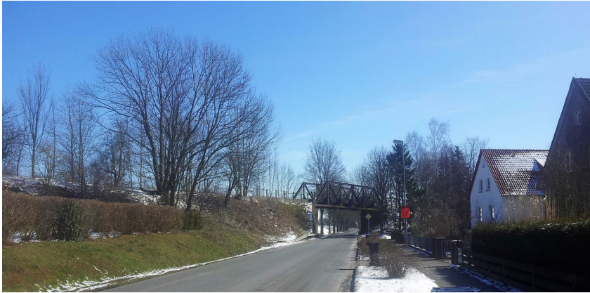
Abb. 207: Eisenbahnbrücke aus der Zeit des Bahn-Betriebs in der ersten Hälfte des 20. Jahrhunderts am Ortsausgang von Almstedt; Aufnahme vom 19.03.2018.
