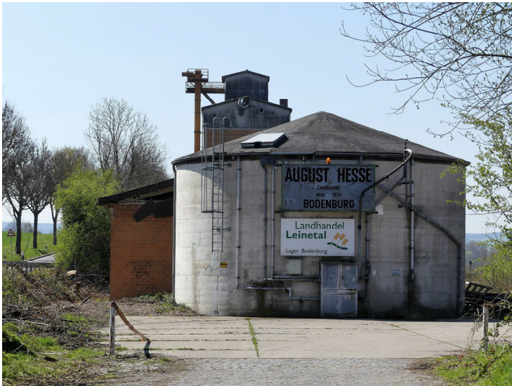
Abb. 187: Kornsilos in Bodenburg von 1851 am Bahnhof (Nachfolgebau); Aufnahme vom 15.04.2019.
