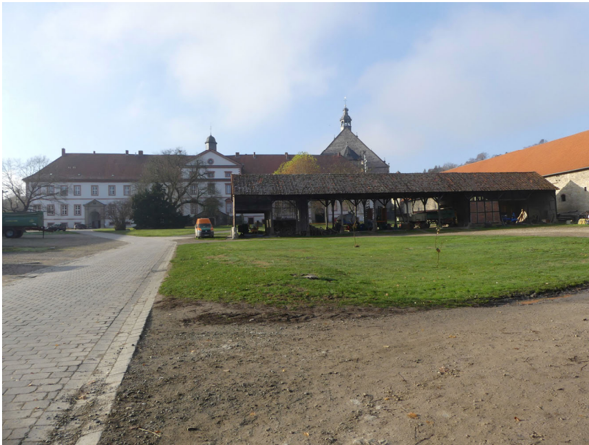
Abb. 223: Abschüssiges Gelände im Klosterhof; Aufnahme vom 17.11.2018.
