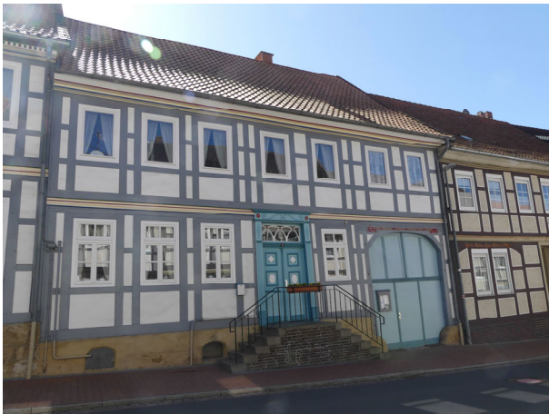
Abb. 186: Sehlemer Straße 9, erbaut 1836 (laut Bemalung im Türsturz). Rechts erkennt man ein Scheunentor; Aufnahme vom 06.04.2018.
