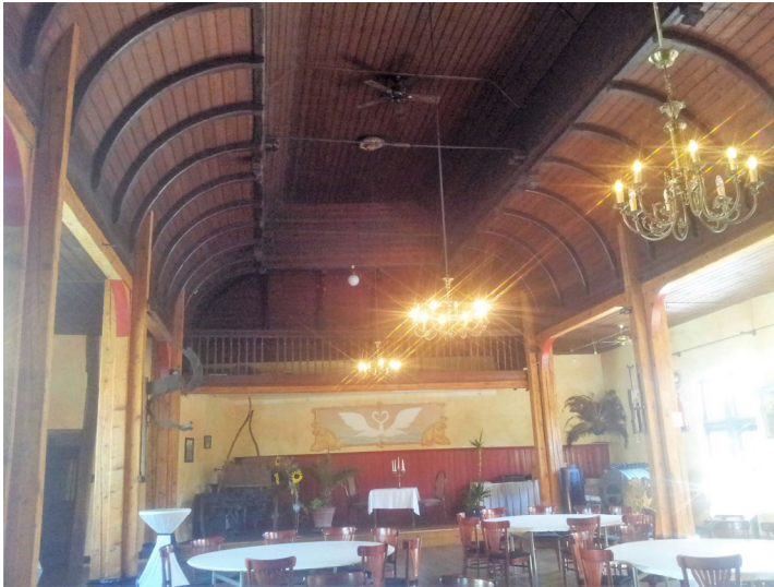
Abb. 206: „Meine's Saal“ in der Almstedter Str. 45, mit Schiffsbodendecke und Jugendstil-Wandverzierungen; Aufnahme vom 19.03.2018.
