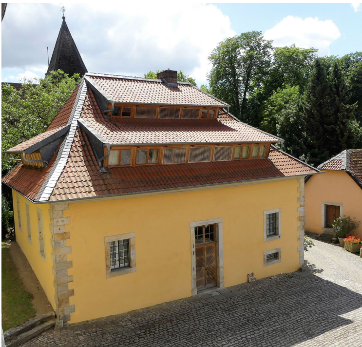
Abb. 98: Ehemalige Brauerei westlich des Unterhofes; Aufnahme vom 21.06.2018.
