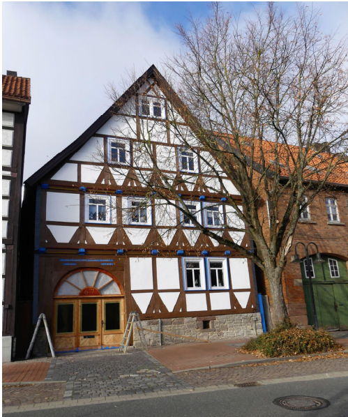
Abb. 241: Hauptstraße 67, Gebäude von 1700; Aufnahme vom 17.11.2018.
